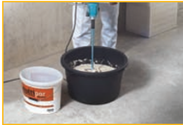
1. Préparer le mortier-colle au malaxeur
