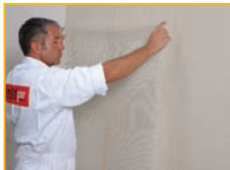
8. Placer la trame avec un chevauchement de 10 cm, puis maroufler
