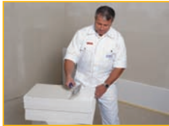
2. Appliquer le mortier sur toute la surface du panneau à la truelle crantée de 10 mm
