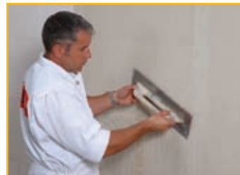
9. Appliquer une 2ème passe d'enduit prêt à l'emploi (application manuelle ou mécanique)
