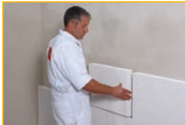
4. Appliquer le panneau. Le décaler d'au moins 20 cm par rapport au rang inférieur
