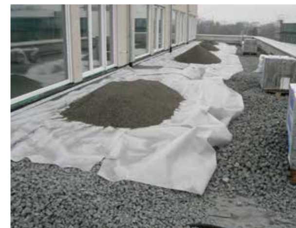
Centre de consommateur EDEKA de Constance, mesure de rénovation avec nouvel aménagement de la surface sur le bâtiment
