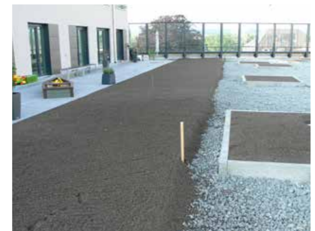
Centre consommateurs EDEKA à Constance, aménagement des allées et des surfaces vertes avec au total 2'000 m 3 de MISAPOR
